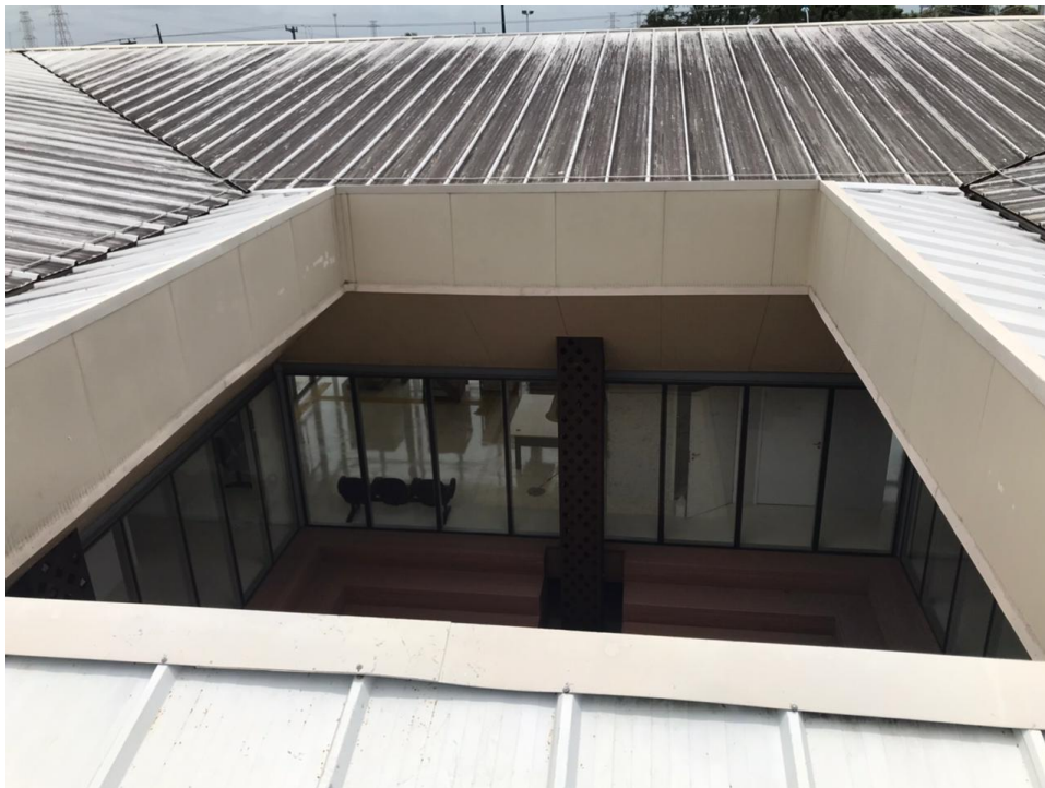
Imagem da cobertura do Laboratório
