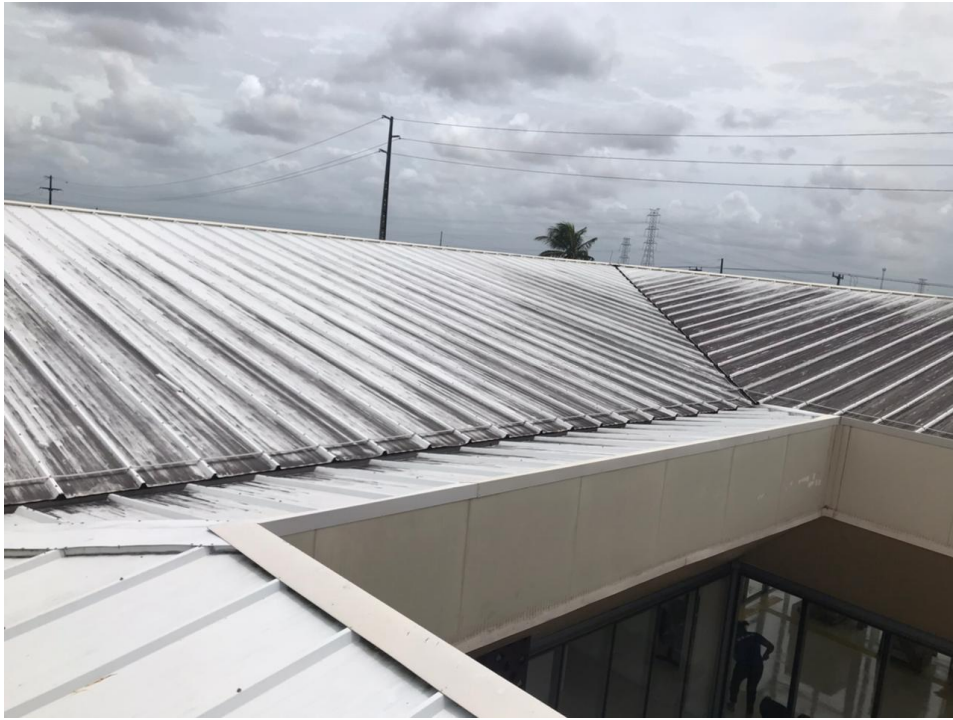
Imagem da cobertura do Laboratório
