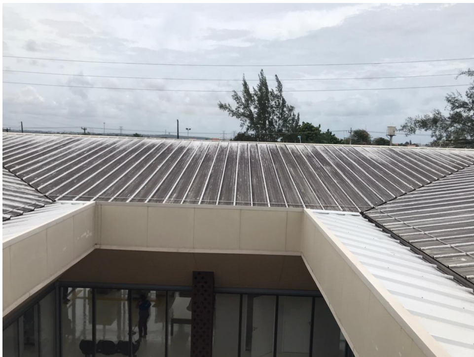
Imagem da cobertura do Laboratório
